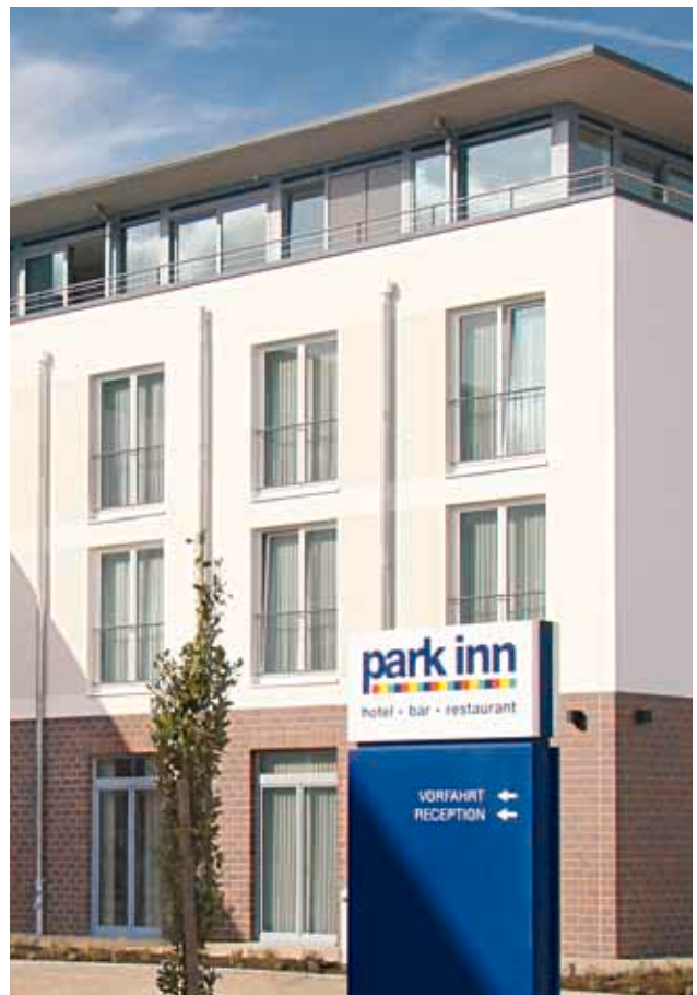
Hotelfassade in Papenburg, Erdgeschoß: ABC-Keramikfassade auf WDV-System, Farbe: Naturbrand glatt Architekt: Dipl. Ing. Hartmut Kapels, Zetel
