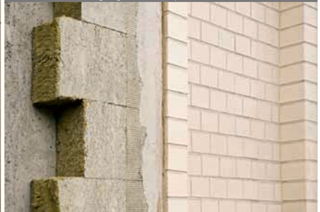
Quartiersteinverlegung auf WDV-System
